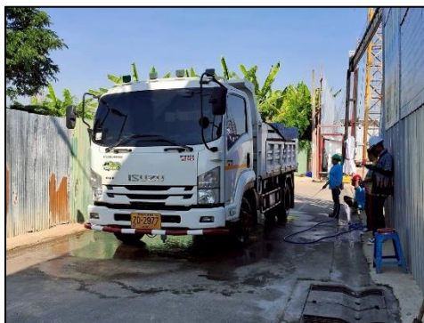
รูปที่ 57 พื้นที่สำหรับล้างทำความสะอาดล้อรถบรรทุกก่อนออกพื้นที่โครงการ
